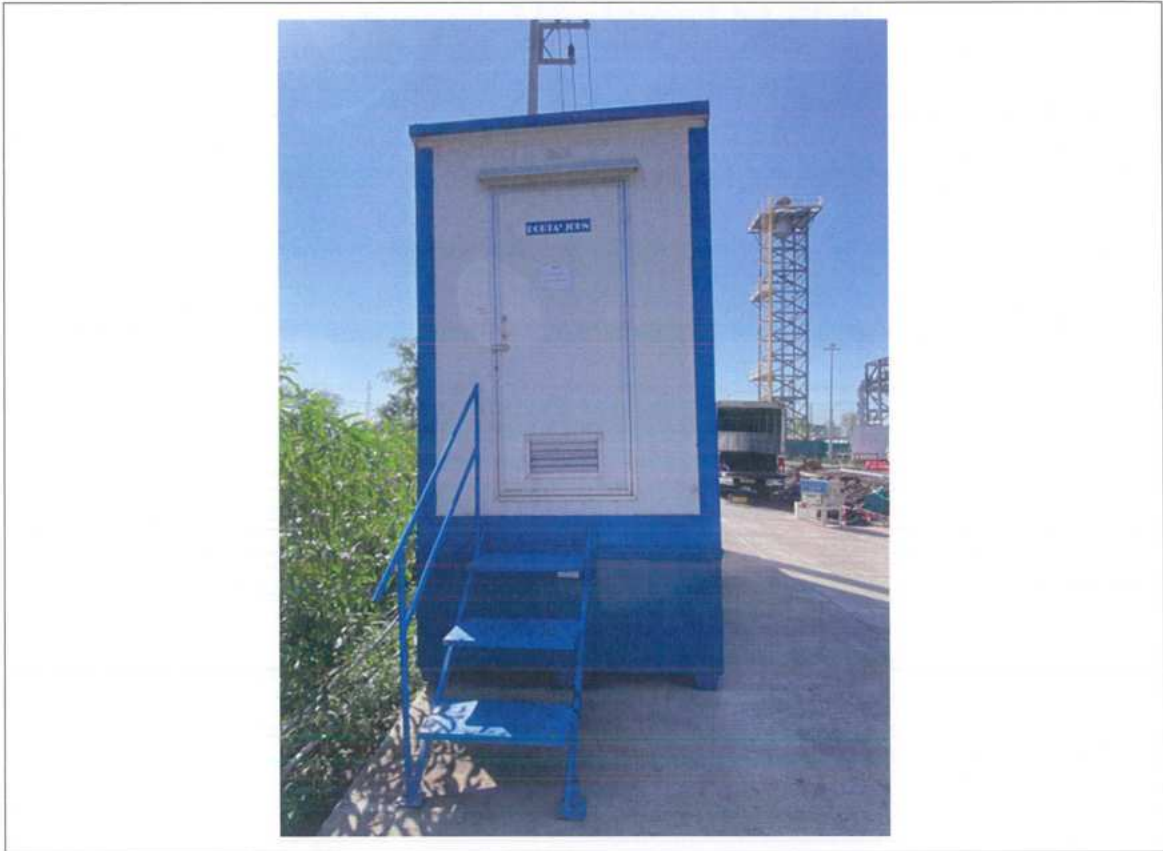
รูปที่ 2.14-5 ตัวอย่างห้องสุขาเคลื่อนที่ พร้อมถังเก็บกักน้ำเสียและสิ่งปฏิกูลปริมาตร 1.5 ลูกบาศก์เมตร
